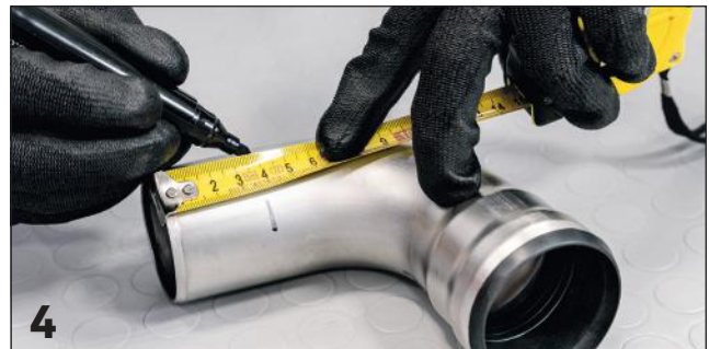
4 Marcatura quota d'innesto / Marking the insertion's depth
