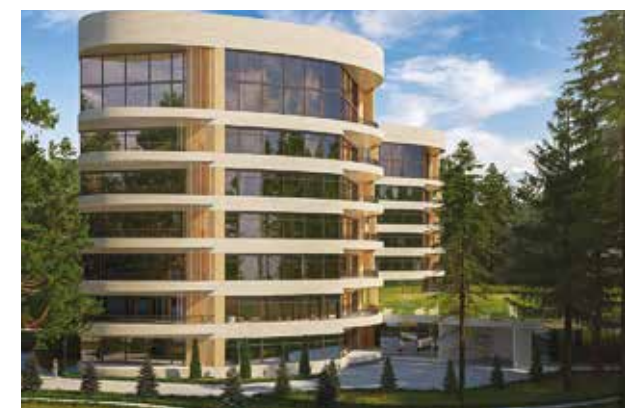
ЖК «Флора и Фауна» г. Новосибирск, 2018-2019 г.г.
